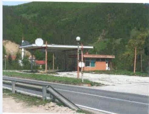
Ugozapsadna fasada sa priključkom na M-5
