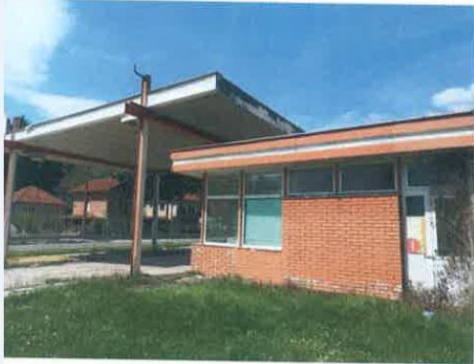
Južna fasada sa nadstrešnicom
