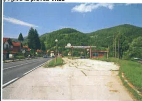
Magistralna cesta M-5 prilaz objektu pogled iz pravca Vitez
